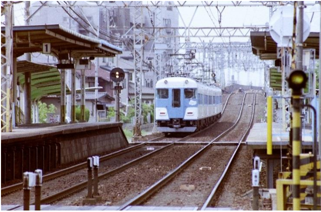
●高架になる前の伏屋駅
