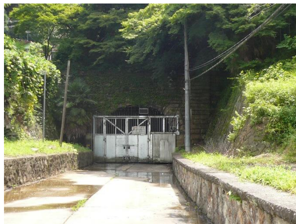
近代化産業遺産 旧生駒トンネル
