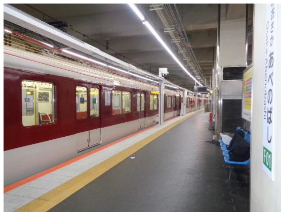
工事の様子（上昇時）
