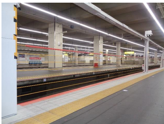
工事の様子（降下時）
